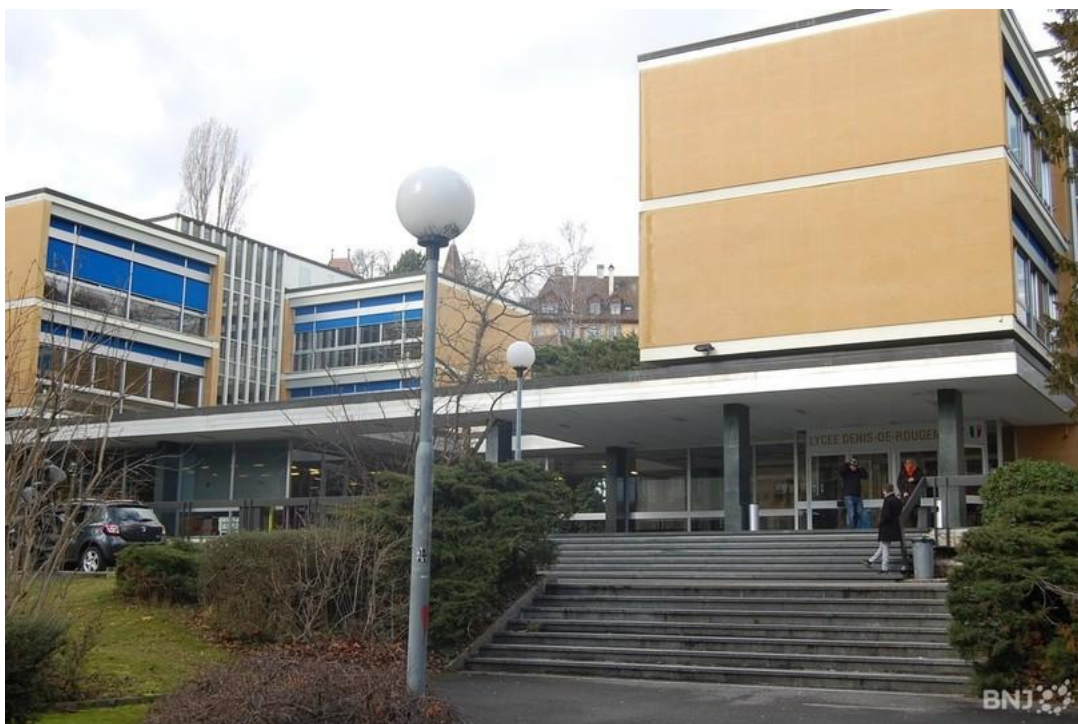
Le bâtiment du Lycée Denis-de-Rougemont situé au faubourg de l'Hôpital 59 à Neuchâtel doit être assaini.
